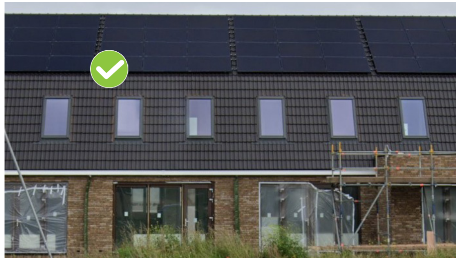
Plaatsing van zonnepanelen volgt de dakvorm.
